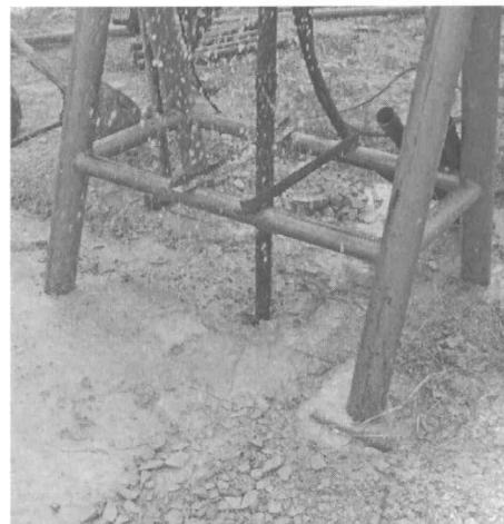
FAENA DE PERFORACIÓN ROTATIVA CON RECIRCULACIÓN DE BENTONITA
