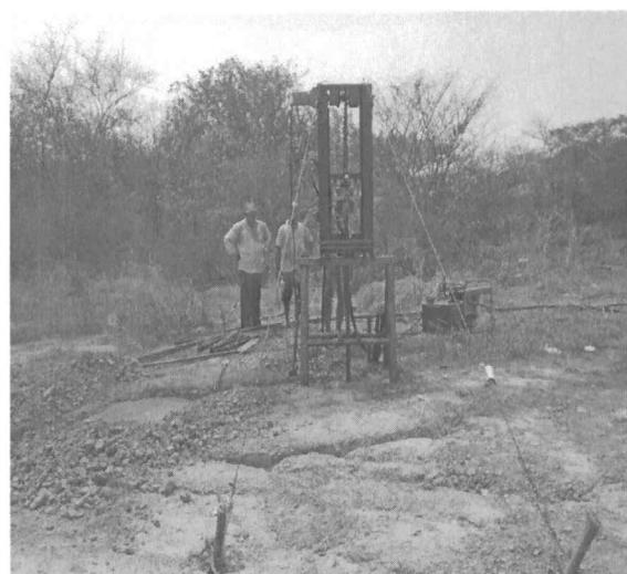
FAENA DE PERFORACIÓN ROTATIVA CON RECIRCULACIÓN DE BENTONITA
